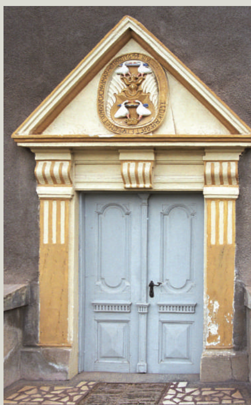
880. Hunedoara. Biserica reformată. Portal. 1644
